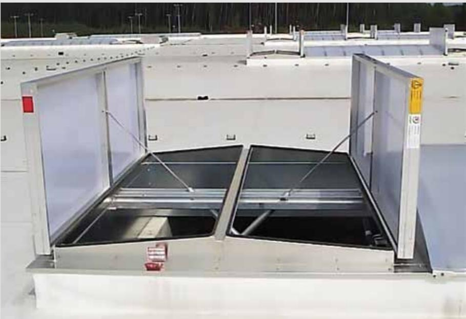
configurato inoltre con motore a 230V con permeabilità all'aria EN 12207 – impermeabilità all'acqua EN 12208 - Resistenza al carico del vento EN 12210
