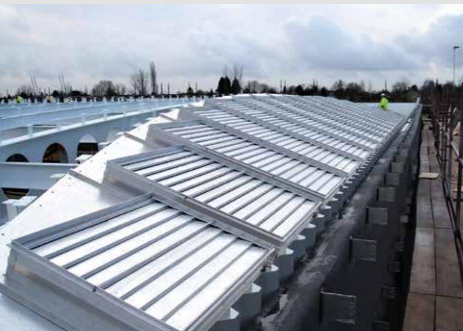
sincronizzazione delle lamelle. A seconda del tipo di azionamento, l'angolo di apertura massimo delle finestre lamellari è fino a 90°
